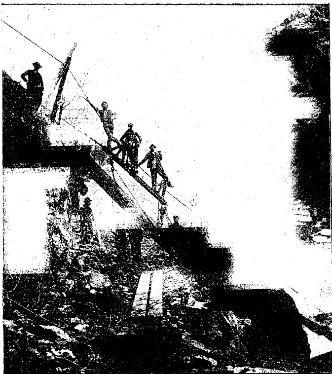
POSE D'UNE CONDUITE FORCÉE EN FLANC DE COTEAU
