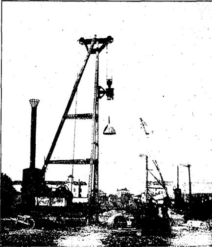
Fig. 4. — Fondation par compression mécanique du sol. Vue du pilon d'épreuve.
