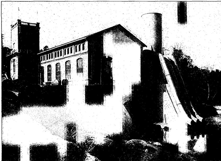
*Fig. 1. — Usine d'Entraygues. — Cheminée d'équilibre avec ses tuyaux de décharge
