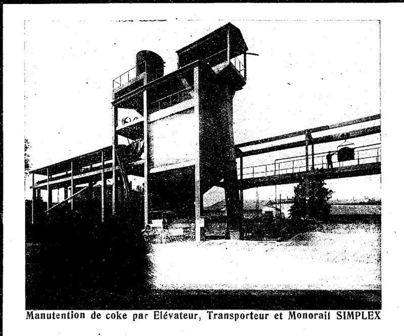
Manutention de coke par Elévateur, Transporteur et Monorail SIMPLEX
