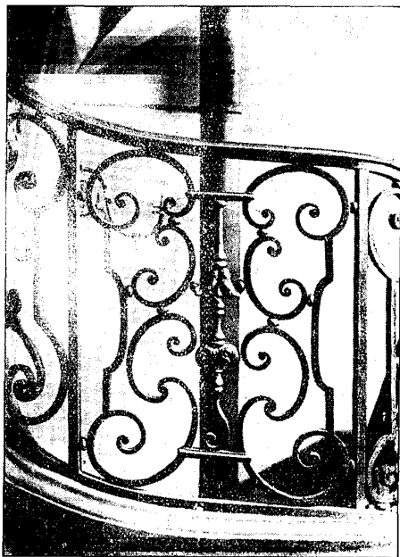
Fig. 5. — Rampe de fer forgé : produit de la serrurerie.
