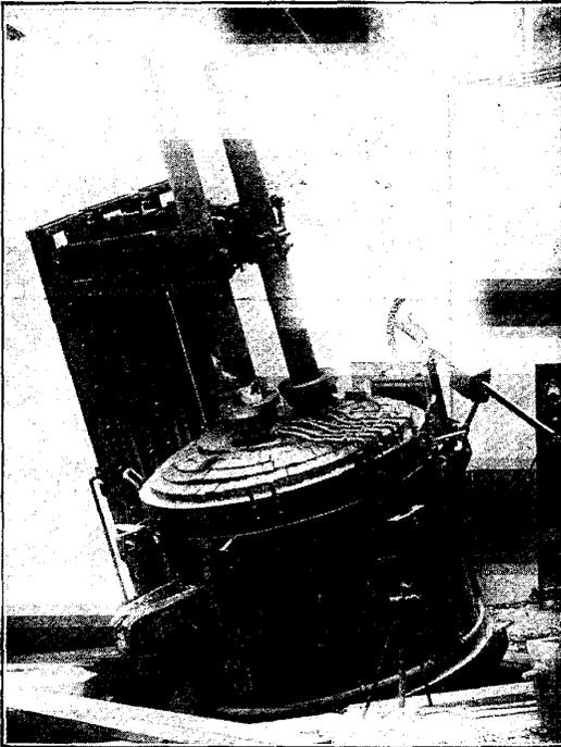
Four électrique de deux tonnes, type Héroult
