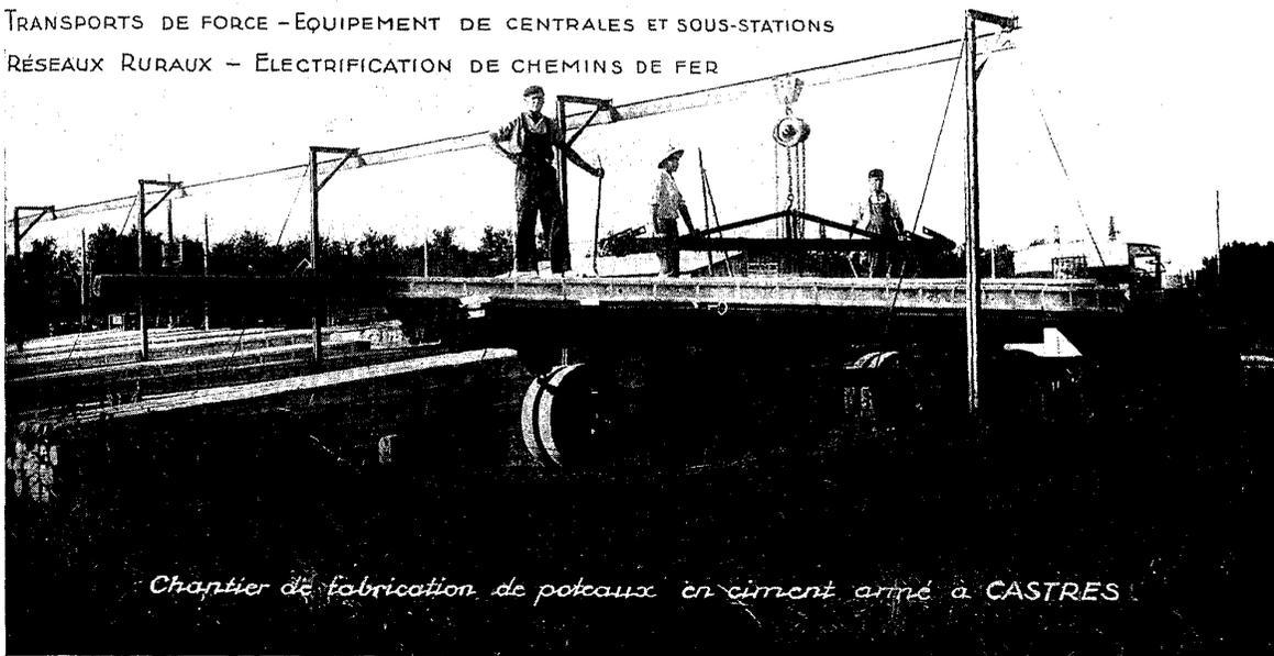
*Chantier de fabrication de poteaux en ciment armé à CASTRES*
