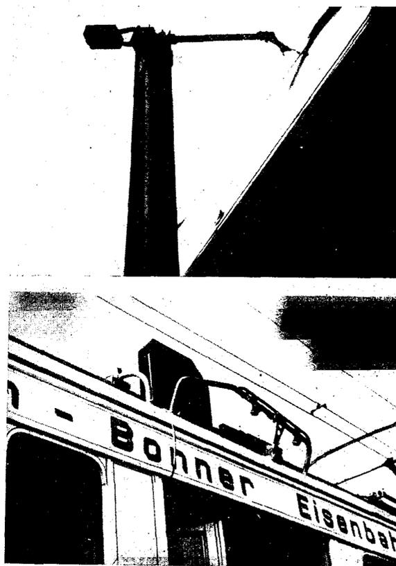
Fig. 7 et 8. — Dispositif en service sur la ligne Cologne-Bonn (on remarquera les étriers sur le toit du véhicule électrique).
