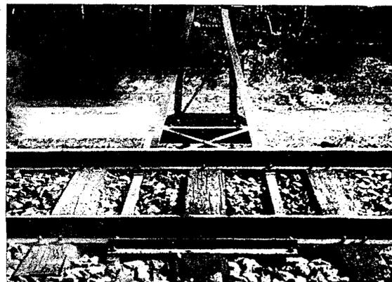
Fig. 9. — Ligne Cologne-Bonn. Dispositif d'ancrage sur les traverses.
