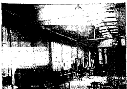
Installation de chauffage.
