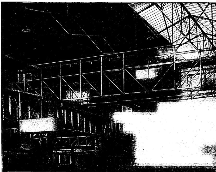
HALL DE 2500 m<sup>2</sup>. — Charpente et Pont roulant entièrement soudés.
