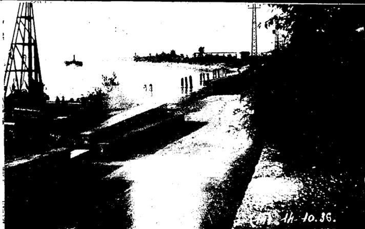
Quai Saint-Gobain, vue du Sud. — On voit l'installation de battage des Ducs d'Albe; au loin, station de pompage et échaffaudage de la passerelle sur le chenal d'accès.
