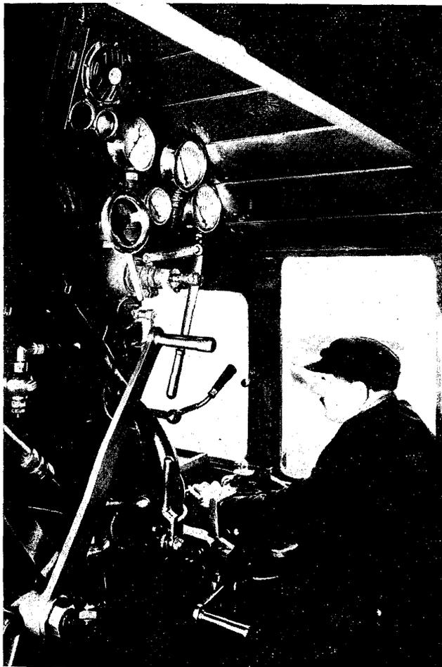
Locomotive munie d'appareil répéteur pour le dispositif de blocage automatique des trains.
