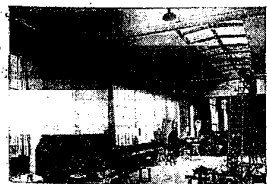
Installation de chauffage.
