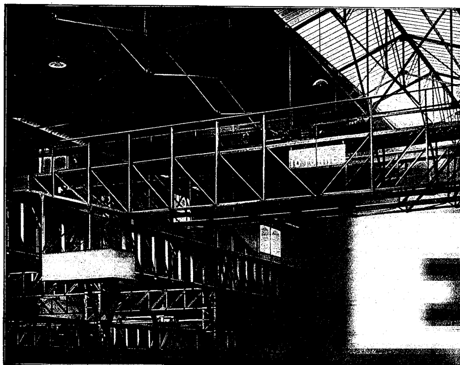
HALL DE 2500 m 2 . — Charpente et Pont roulant entièrement soudés.
