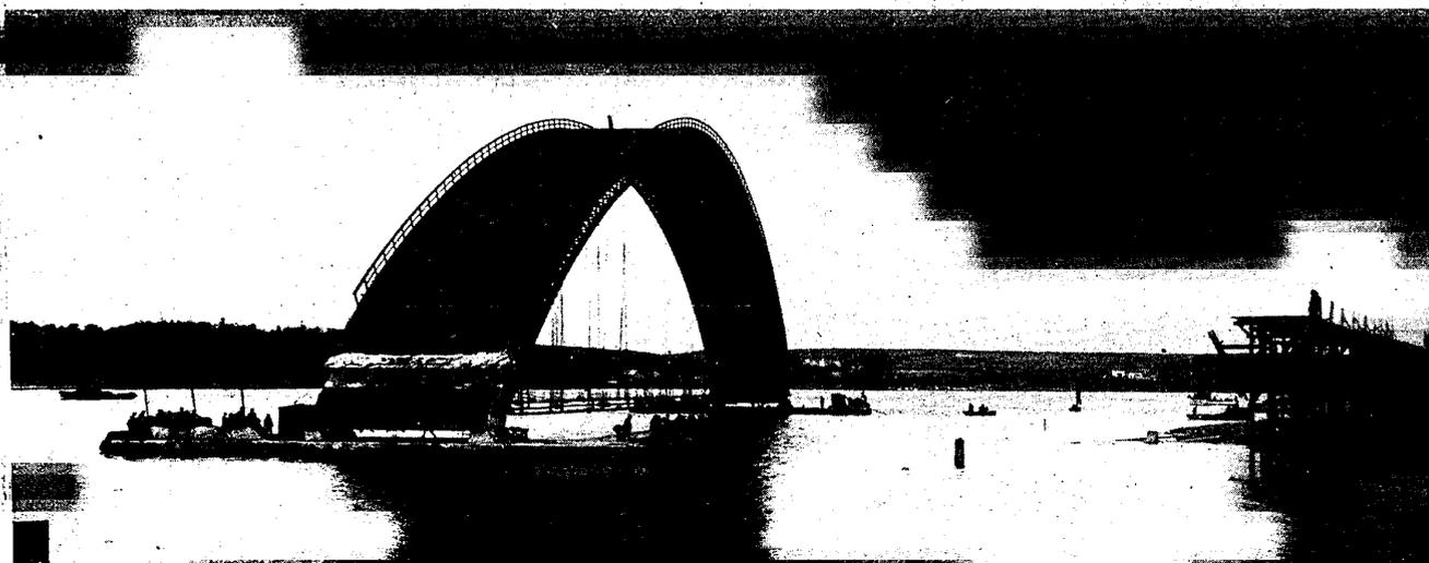
Fig. 13. — Pont Albert-Loupe. Le cintre est déplacé par flottaison sur caissons en ciment armé. (Collection Limousin)
