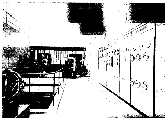
Salle des machines
