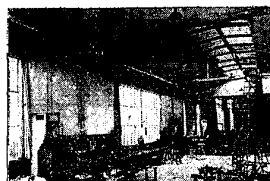
Installation de chauffage.
