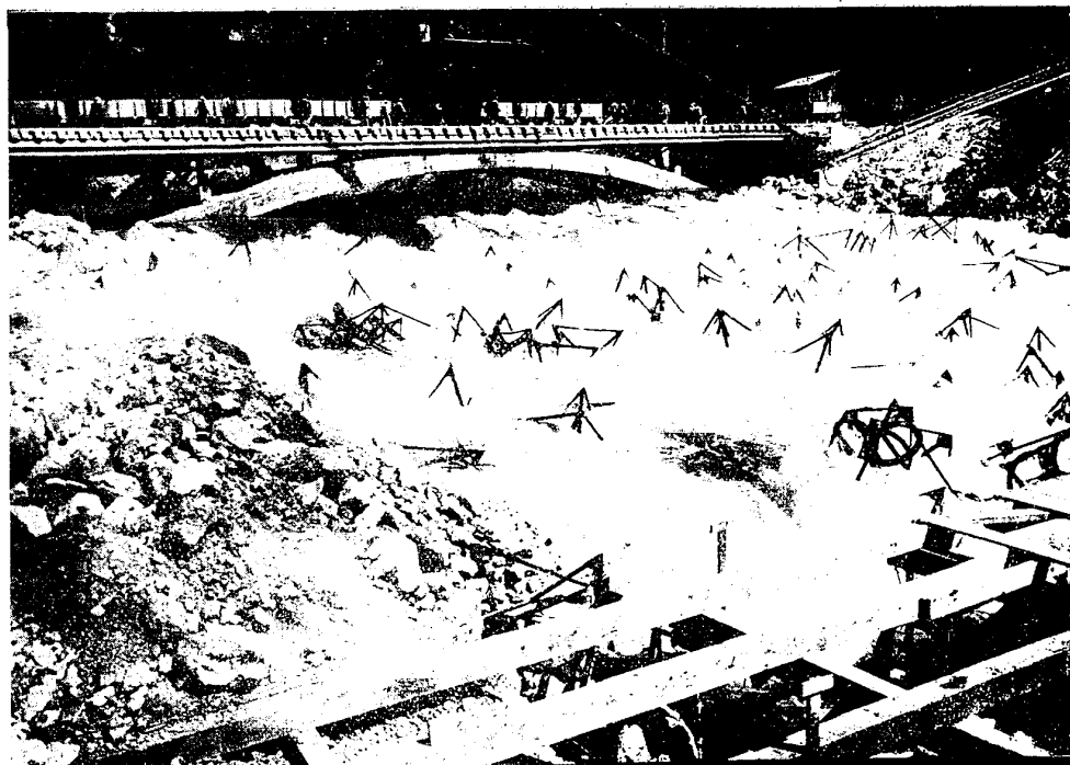
14. — Massif de coupure aval sous un déversement de 60 m 3 par seconde. (Le débit total du Rhône étant de 320 m 3 seconde, dont 260 passent par le souterrain et 60 sur le massif.
