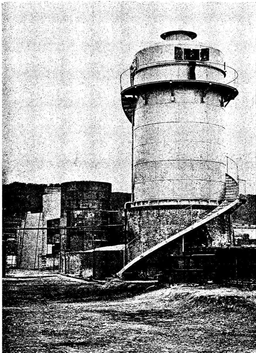
Fig. 46. — Vue extérieure d'un appareil de 100 000 litres pour l'épuration chimique des pétroles.
